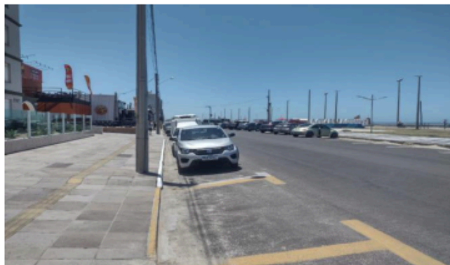
FOTO RUA VISÃO À ESQUERDA
