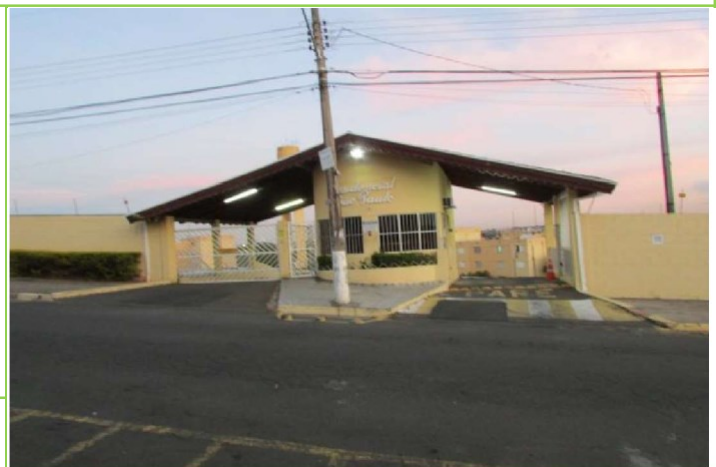
Foto da Fachada do Imóvel
