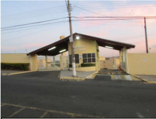
VISTA DA FACHADA DO IMÓVEL EM ESTUDO
