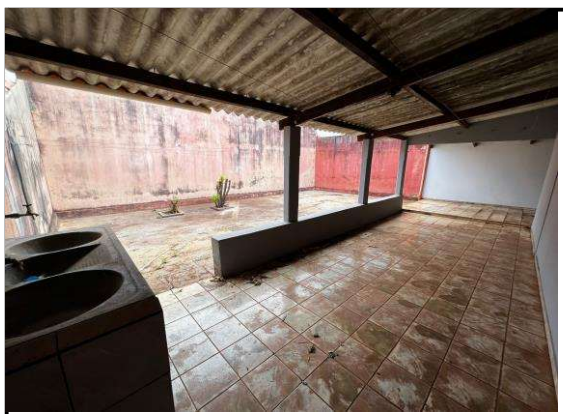
Descrição: ÁREA DE SERVIÇO
