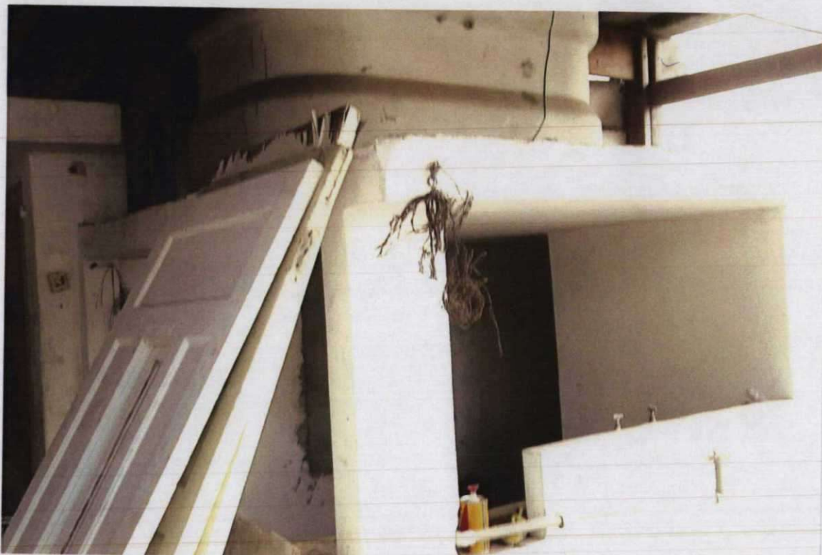
Foto 41 . ESTRUTURA DE CONCRETO E ABERTURA DE ILUMINAÇÃO E VENTILAÇÃO
