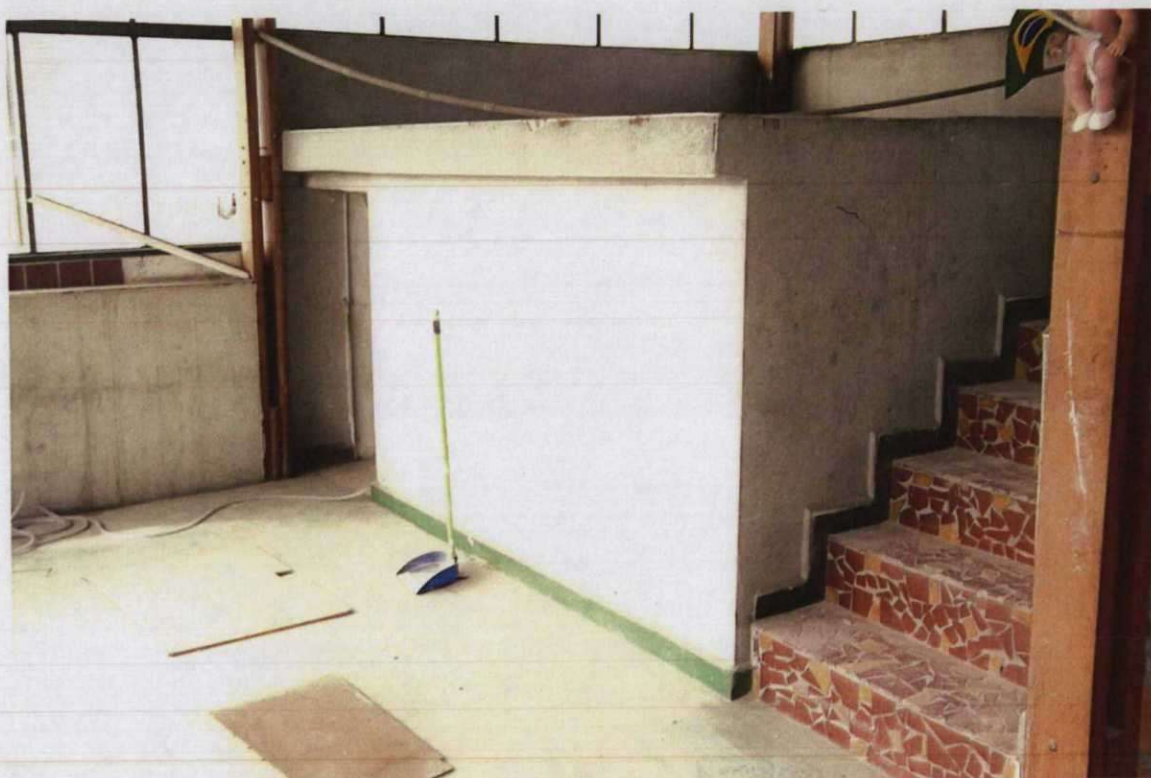
Foto 33 . ACESSO A INSTAÇÕES TÉCNICAS E AO PAVIMENTO SUPERIOR
