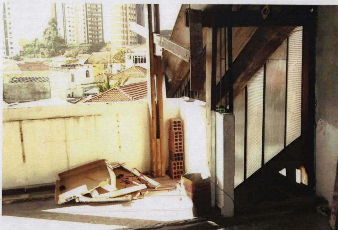
Foto 44 . MESMO ÂNGULO MOSTRANDO PARTE DO CASARIO EM DERREDOR
