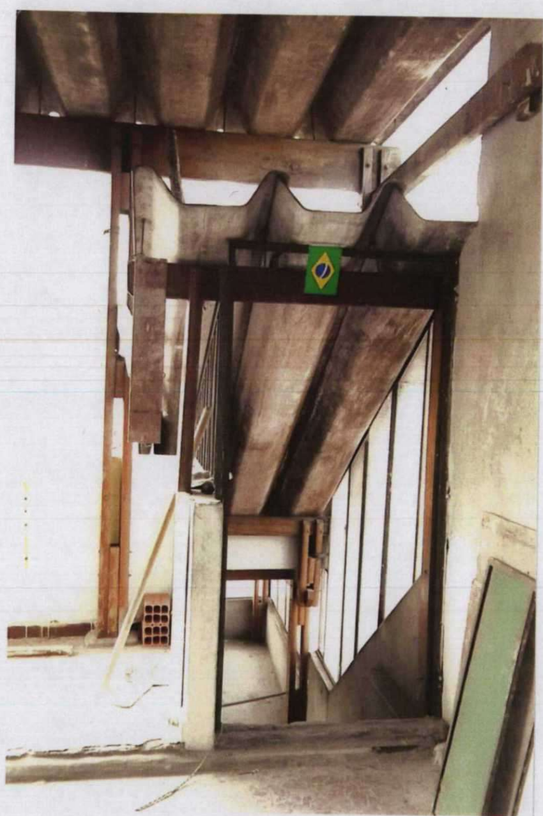
Foto 45 . DETALHES DA COBERTURA DA ESCADA E ILUMINAÇÃO
