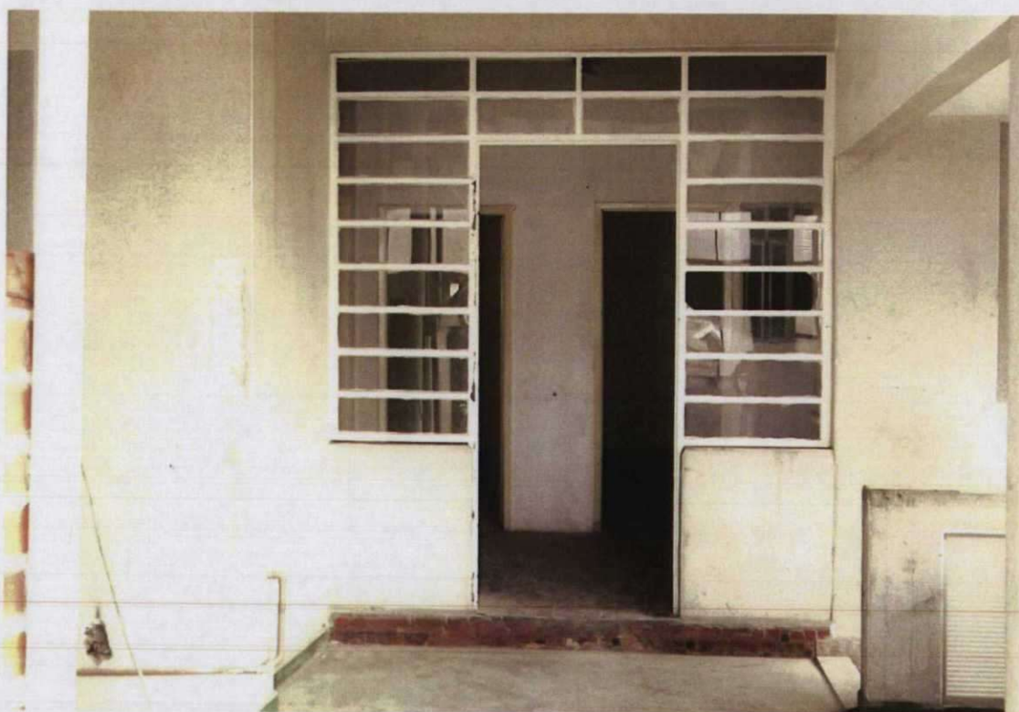
Foto 24 . HALL PRIVATIVO NO PAVIMENTO INTERMEDIÁRIO
