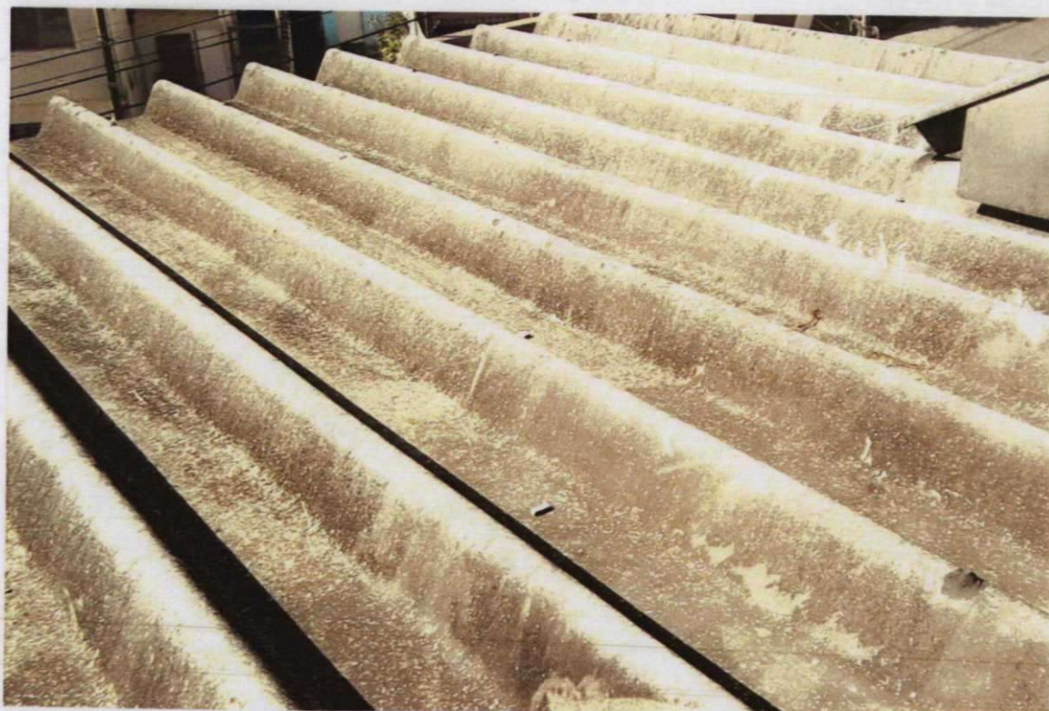
Foto 48 . A COBERTURA EM TELHA CANALETE DE PARTE DO ANDAR INTERMEDIÁRIO
