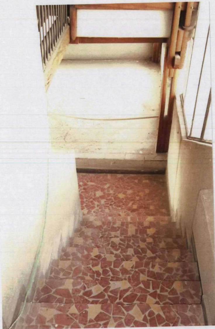
Foto 46 . O PISO DOS DEGRAUS É EM CACO CERÂMICO VERMELHO
