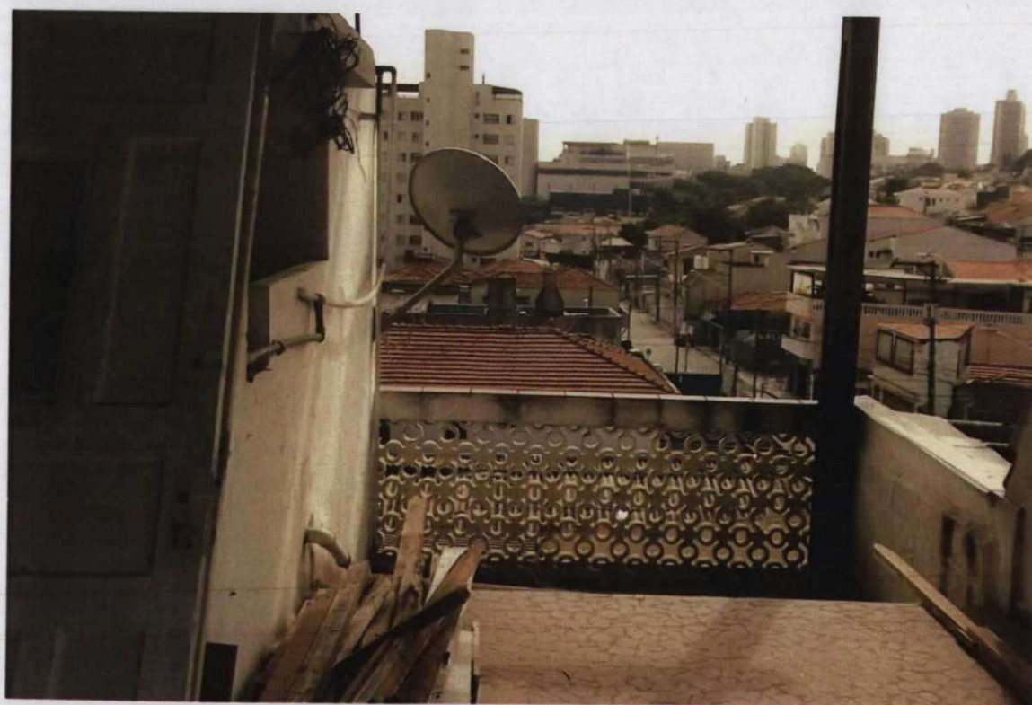
Foto 42 . TERRAÇO E MURETA DE ELEMENTOS VAZADOS E LAJE ESCALONADA
