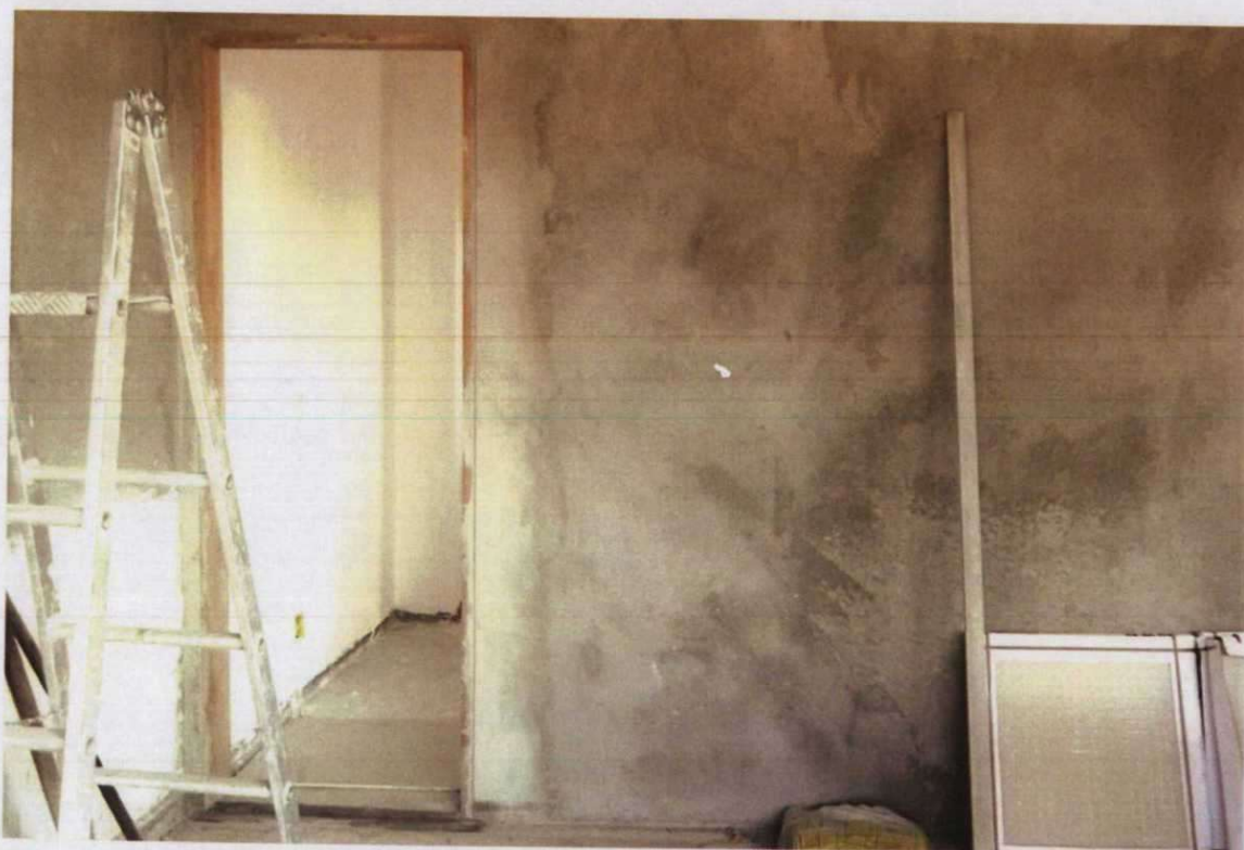
Foto 36 . ABERTURA NA ALVENARIA PARA ACESSO A UMA DAS DUAS SALAS
