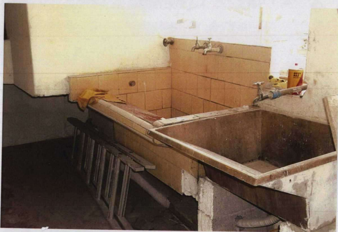
Foto 38 OS DOIS TANQUES E ABERTURA DE ILUMINAÇÃO E VENTILAÇÃO
