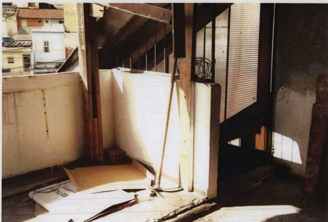
Foto 43 . MURETA E ESCADA QUE DESCE PARA O PAVIMENTO INTERMEDIÁRIO
