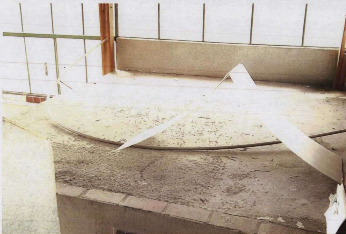
Foto 47 . A LAJE ELEVADA DO RECINTO DE INSTAÇÕES TÉCNICAS
