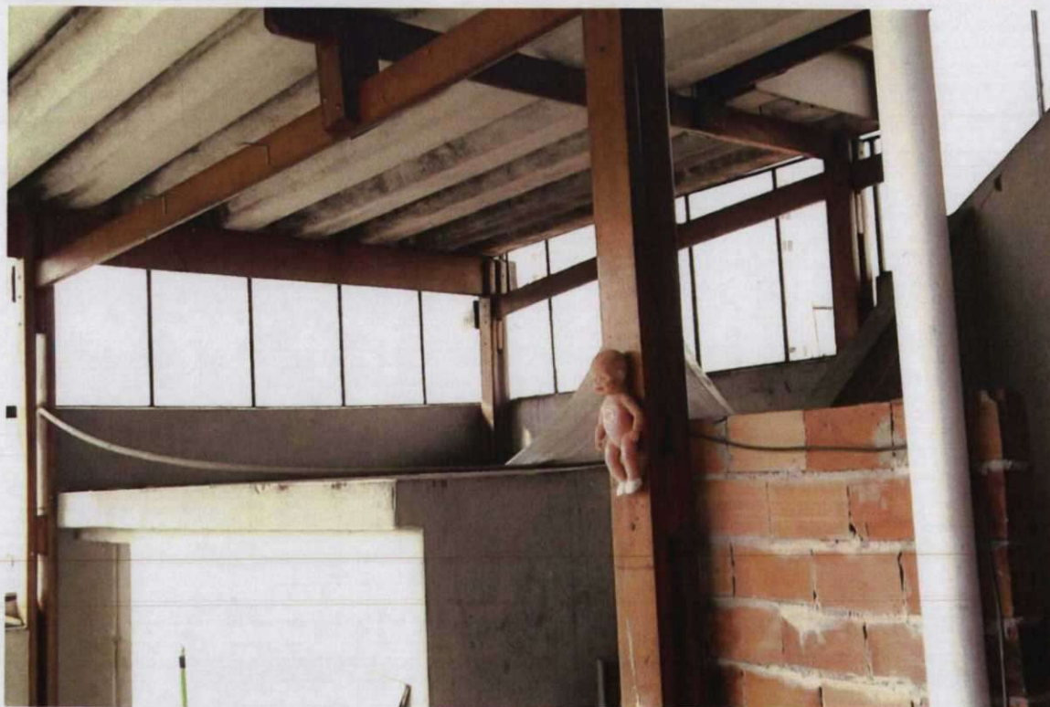
Foto 34 . ENVIDRAÇAMENTO E COBERTURA COM TELHAS CANALETE DA PARTE ANTERIOR DO ANDAR INTERMEDIÁRIO
