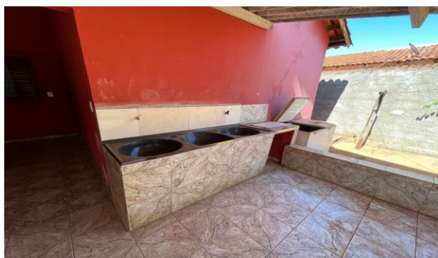
Descrição: VISTA PARCIAL INTERNA DO IMÓVEL
