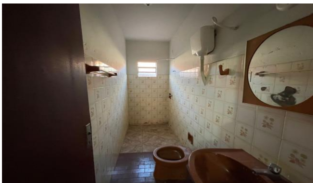
Descrição: VISTA PARCIAL INTERNA DO IMÓVEL
