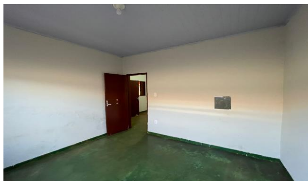
Descrição: VISTA PARCIAL INTERNA DO IMÓVEL
