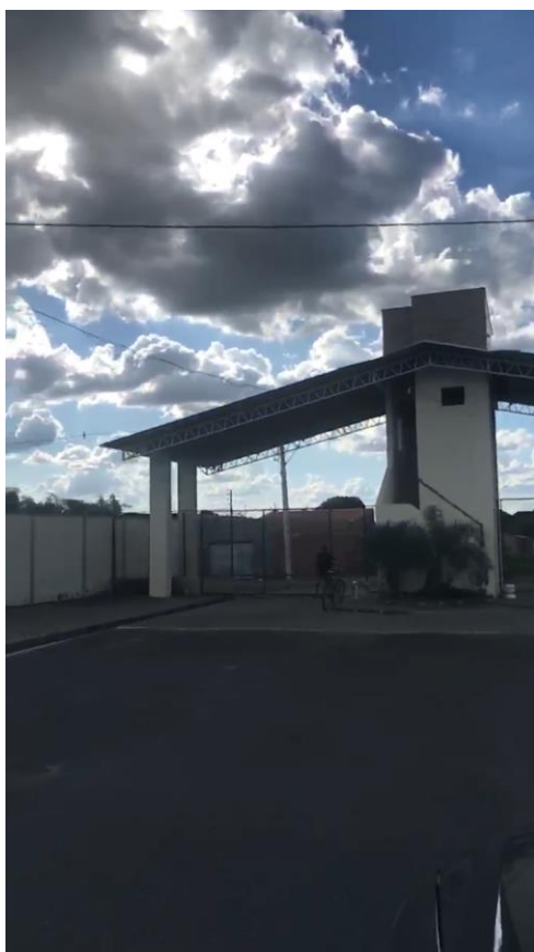
Portaria - vista interna
