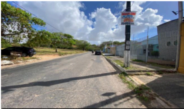
FOTO RUA VISÃO À ESQUERDA
