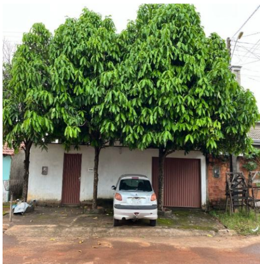
Fachada do avaliando
