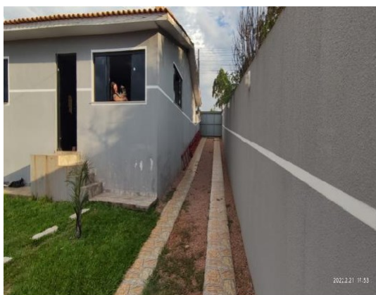
VISTA PARCIAL DO ACESSO CASA 02
