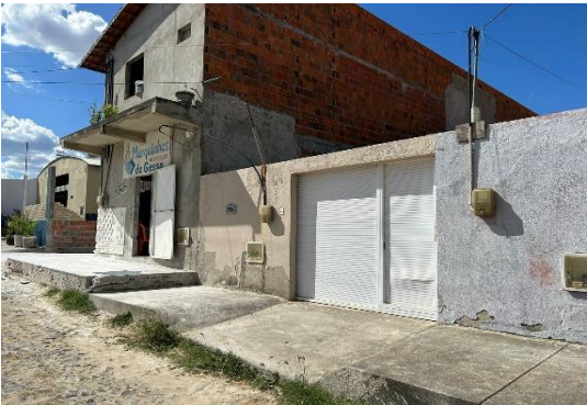
Fachada do avaliando
