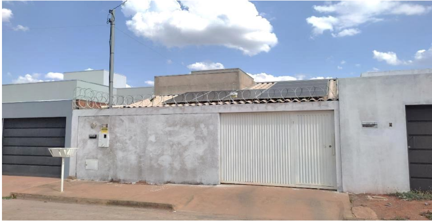
Fachada do avaliando
