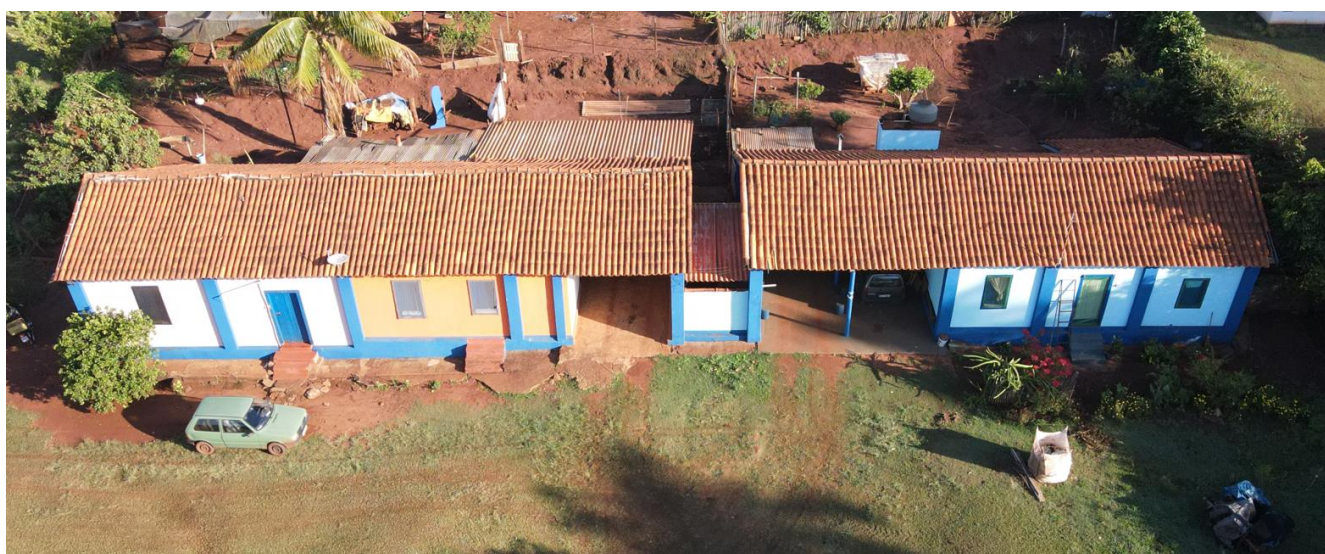
Figura 15 - Construção 9 e 10 - Casas antigas em bom estado de conservação externo
