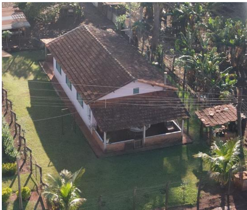
Figura 17 - Construção 12 - Casa antiga em bom estado de conservação externo
