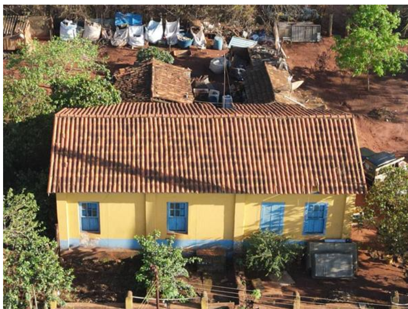
Figura 18 - Construção 13 - Casa antiga e em bom estado de conservação externo
