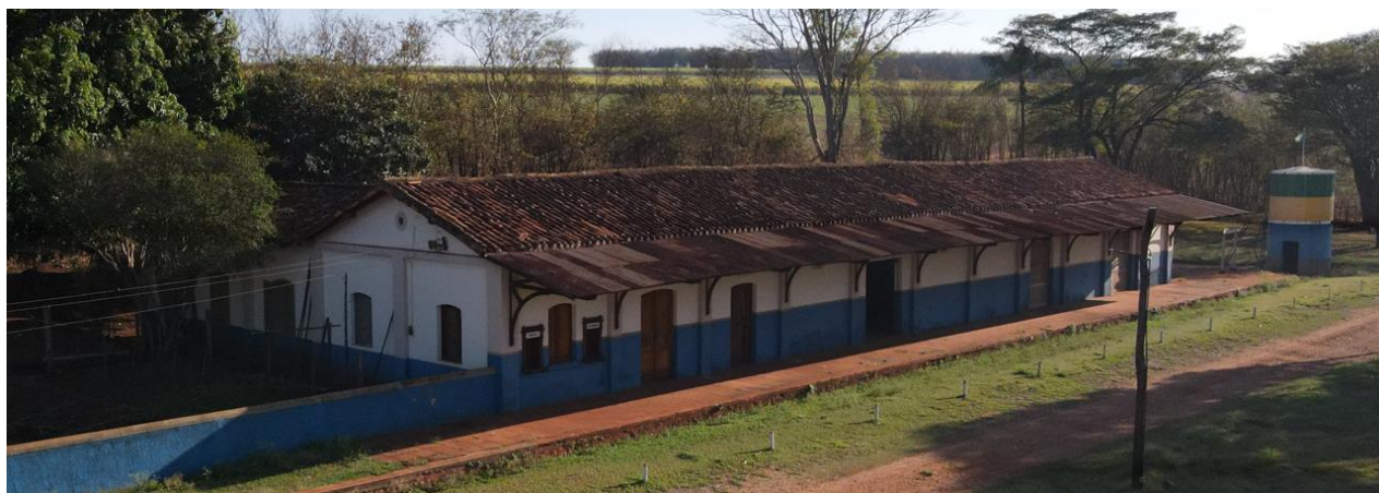
Figura 19 - Construção 14 - Antiga estação de trem, bom estado de conservação externo
