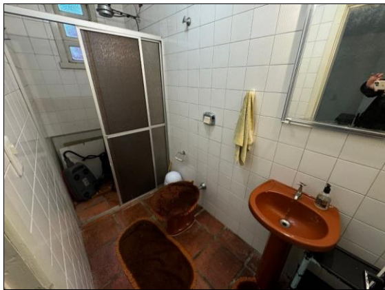
Descrição: Banheiro de serviço
