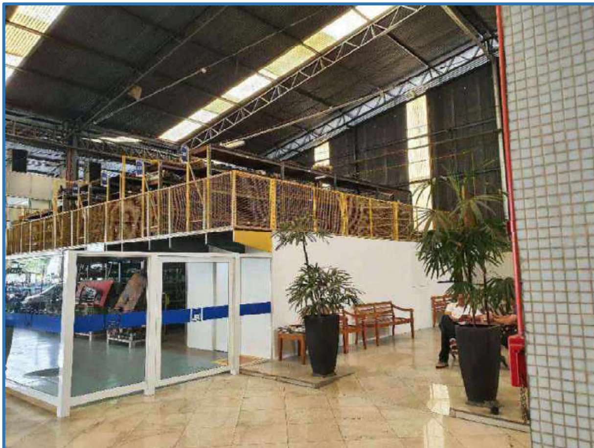
Foto 8 – Vista geral do imóvel avaliando, cuja construção está incorporada aos lotes adjacentes, observando-se seu padrão construtivo e estado de conservação.
