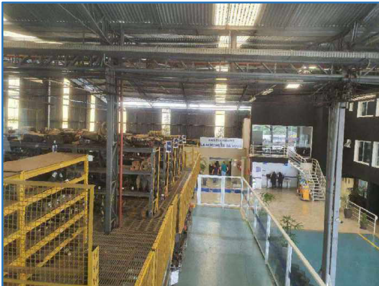
Foto 9 – Vista geral do imóvel avaliando, cuja construção está incorporada aos lotes adjacentes, observando-se seu padrão construtivo e estado de conservação.
