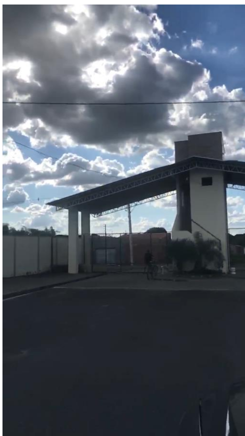
Portaria - vista interna
