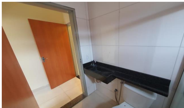
Descrição: BANHEIRO SUÍTE
