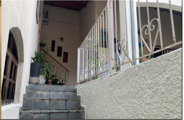
Escada para residência
