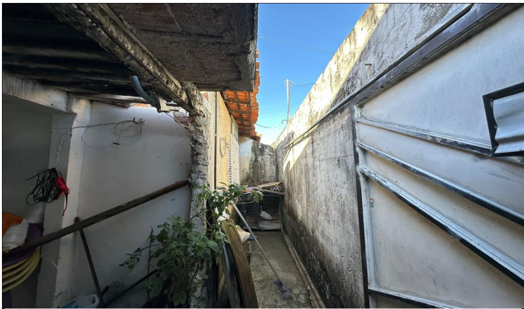
Descrição: VISTA PARCIAL INTERNA DO IMÓVEL
