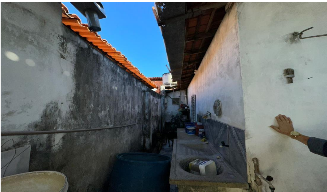
Descrição: VISTA PARCIAL INTERNA DO IMÓVEL
