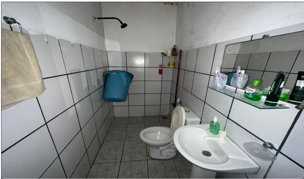
Descrição: VISTA PARCIAL INTERNA DO IMÓVEL
