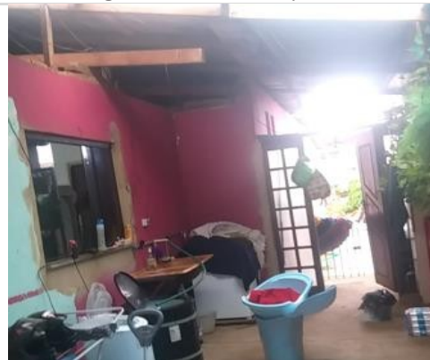
Garagem - entrada lateral para a casa
