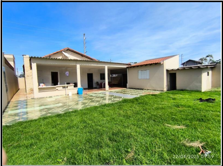
Descrição: VISTA DO IMÓVEL
