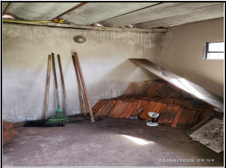
Descrição: VISTA DO IMÓVEL
