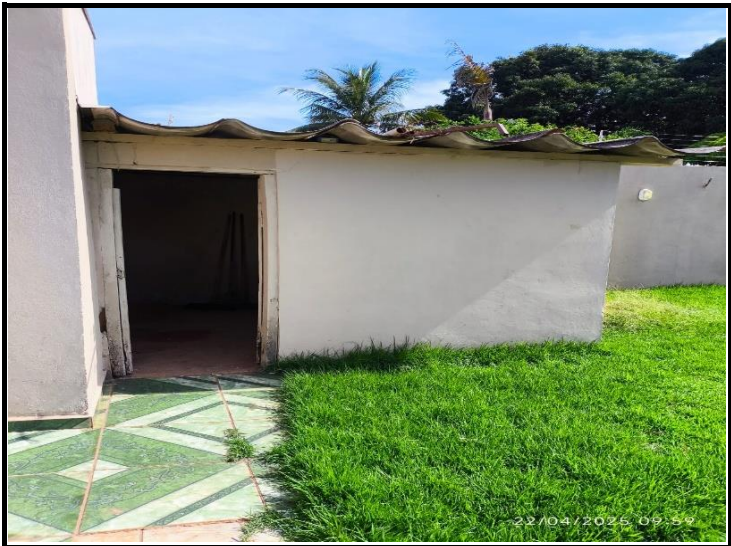
Descrição: VISTA DO IMÓVEL
