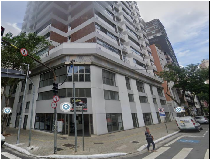
VISTA DA FACHADA DO IMÓVEL EM ESTUDO
