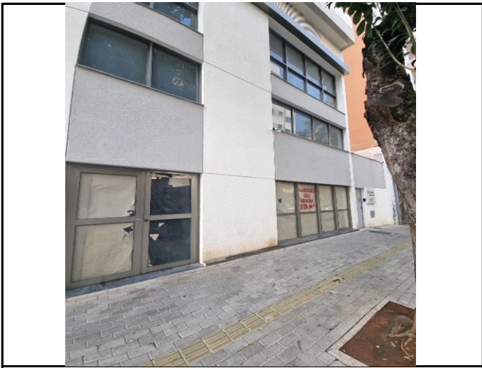
VISTA DA FACHADA DO IMÓVEL EM ESTUDO
