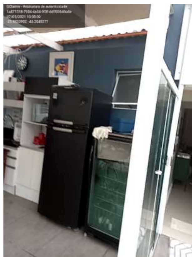
Cozinha - vista 3 - Colocação de forro de gesso
