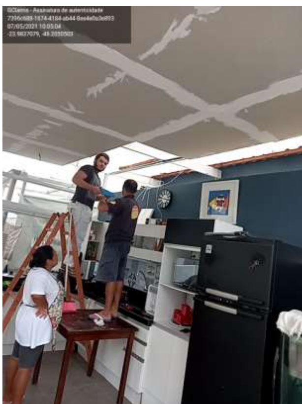
Cozinha - vista 2 - Colocação de forro de gesso
