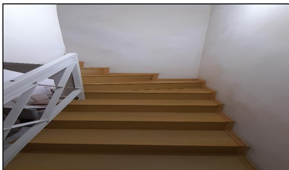
Descrição: VISTA PARCIAL ESCADA
