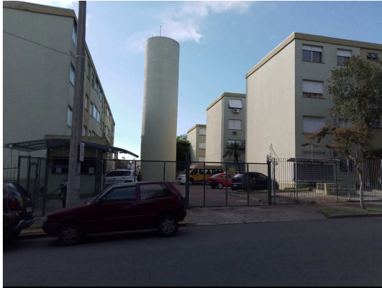
VISTA DA FACHADA DO IMÓVEL EM ESTUDO
