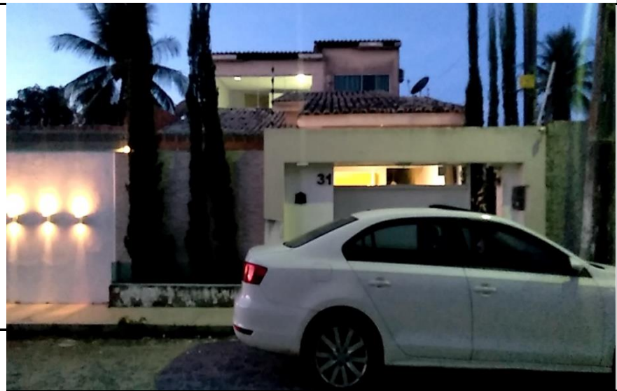
Foto da Fachada do Imóvel
