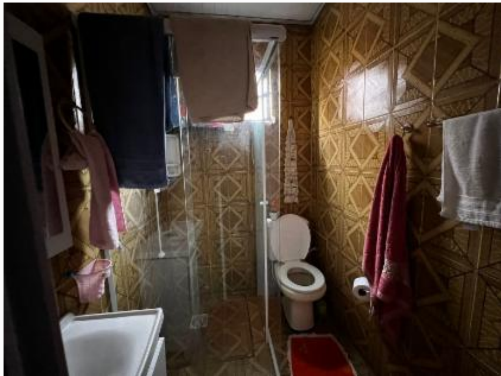
Banheiro social - vista 2
