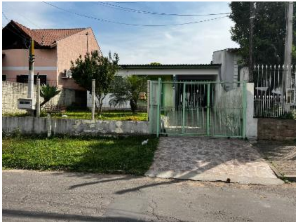
Fachada do avaliando
