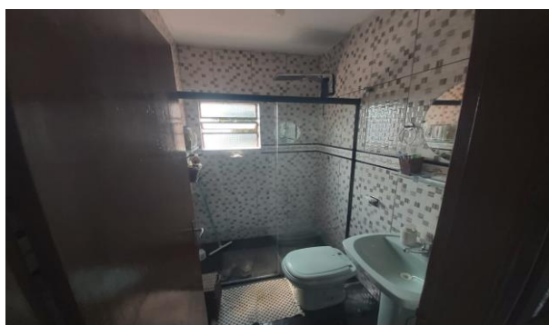
Descrição: Banheiro social
