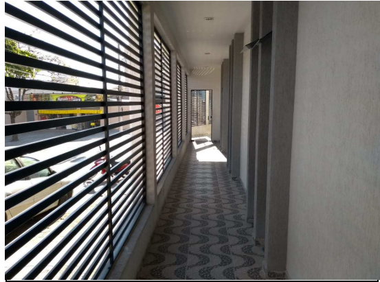
LATERAL DO IMÓVEL
