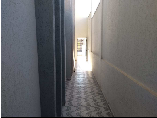
LATERAL DO IMÓVEL
