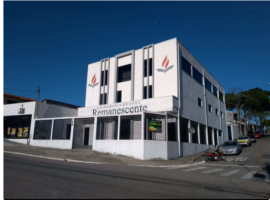
VISTA DA FACHADA DO IMÓVEL EM ESTUDO
