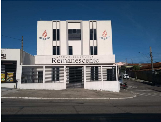
VISTA DA FACHADA DO IMÓVEL EM ESTUDO
