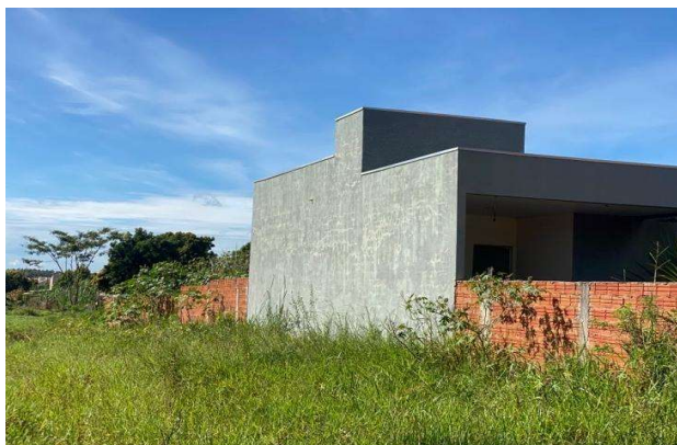
Fachada avaliando - Vista 04
