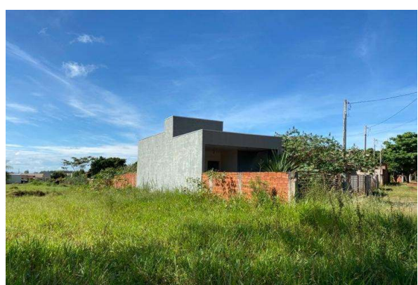
Fachada avaliando - Vista 05
