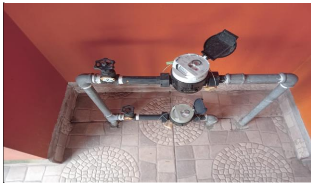
Descrição: Hidrômetro
