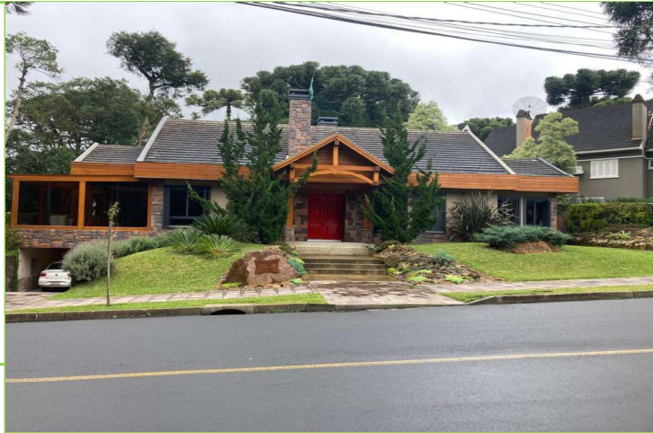
Foto da Fachada do Imóvel
