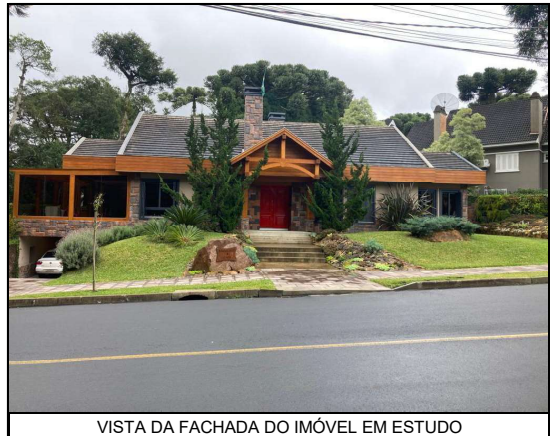
VISTA DA FACHADA DO IMÓVEL EM ESTUDO
