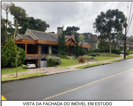
VISTA DA FACHADA DO IMÓVEL EM ESTUDO
