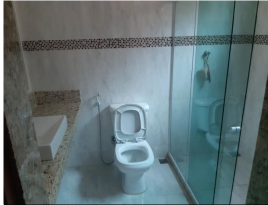
VISTA PARCIAL INTERNA DO BANHEIRO SUÍTE
