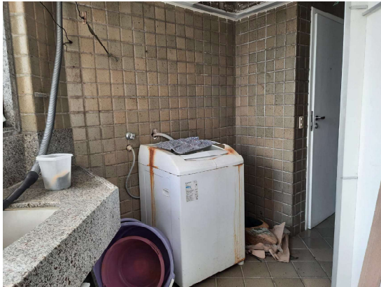
VISTA PARCIAL INTERNA DA ÁREA DE SERVIÇO
