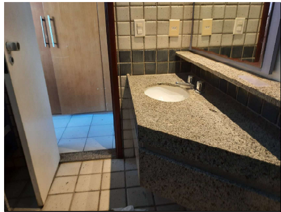
VISTA PARCIAL INTERNA DO BANHEIRO (SUÍTE)
