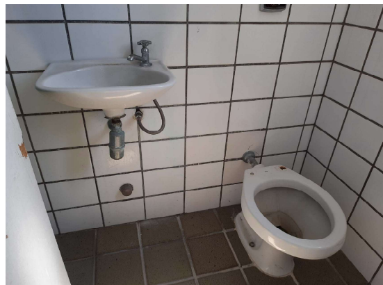
VISTA PARCIAL INTERNA DO BANHEIRO DE SERVIÇO
