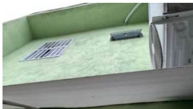
Pavimento superior - vista externa
