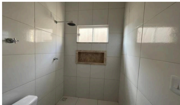
Descrição: BANHEIRO SUÍTE
