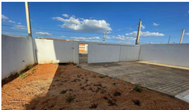
Descrição: ENTRADA DO IMÓVEL/ GARAGEM
