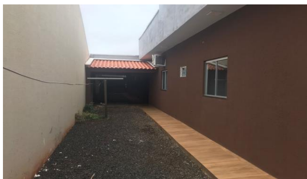
Descrição: VISTA PARCIAL INTERNA DO IMÓVEL
