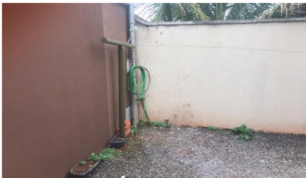
Descrição: VISTA PARCIAL INTERNA DO IMÓVEL
