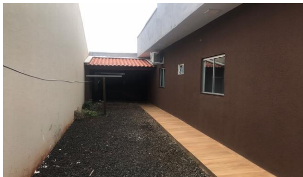
Descrição: VISTA PARCIAL INTERNA DO IMÓVEL
