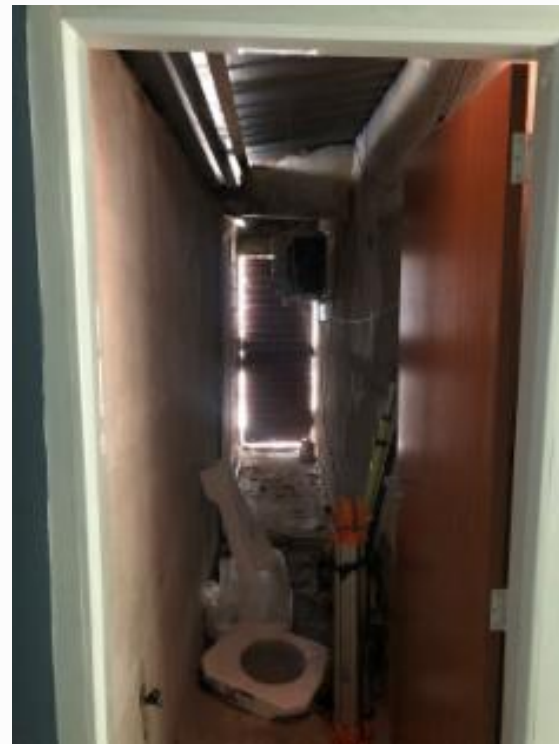
Corredor externo coberto
