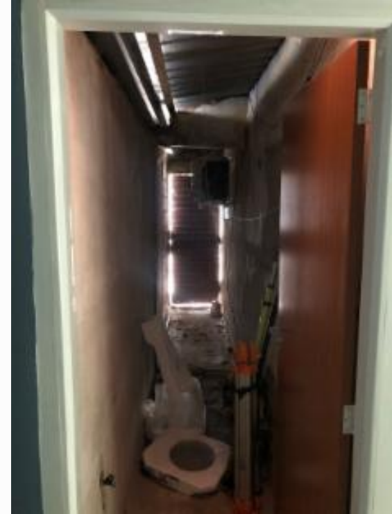
Corredor externo coberto
