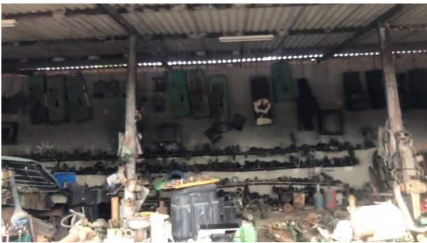
Vista geral espaço coberto
