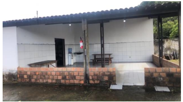
Fachada área de lazer com varanda
