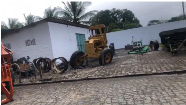
Frente construção 2 (estoque)
