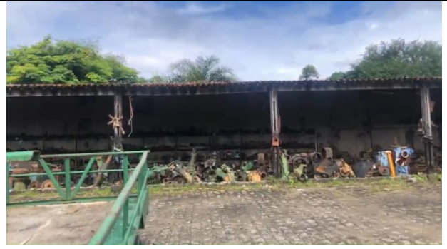
Vista geral espaço coberto
