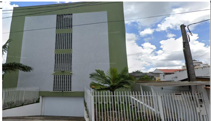
Foto da Fachada do Imóvel
