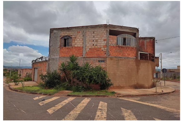
Fachada do avaliando - vista 03
