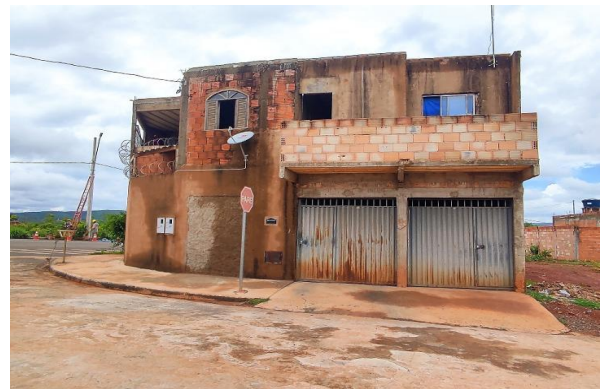
Fachada do avaliando - vista 05
