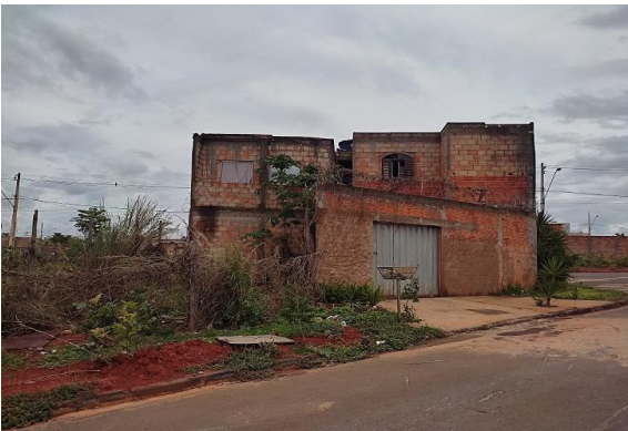
Fachada do avaliando - vista 04
