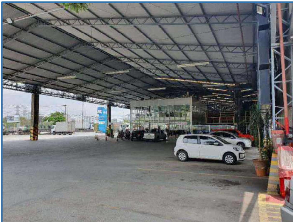
Foto 10 – Vista geral do galpão ocupado pela JR Diesel, que inclui o imóvel avaliando.
