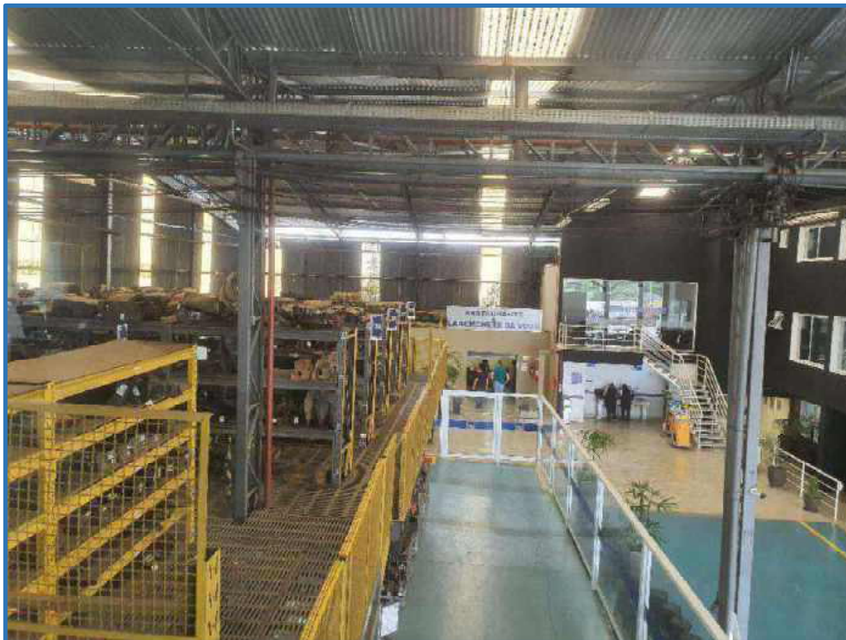
Foto 9 – Vista geral do imóvel avaliando, cuja construção está incorporada aos lotes adjacentes, observando-se seu padrão construtivo e estado de conservação.
