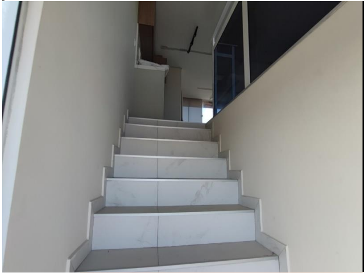
Descrição: VISTA PARCIAL INTERNA DO IMÓVEL
