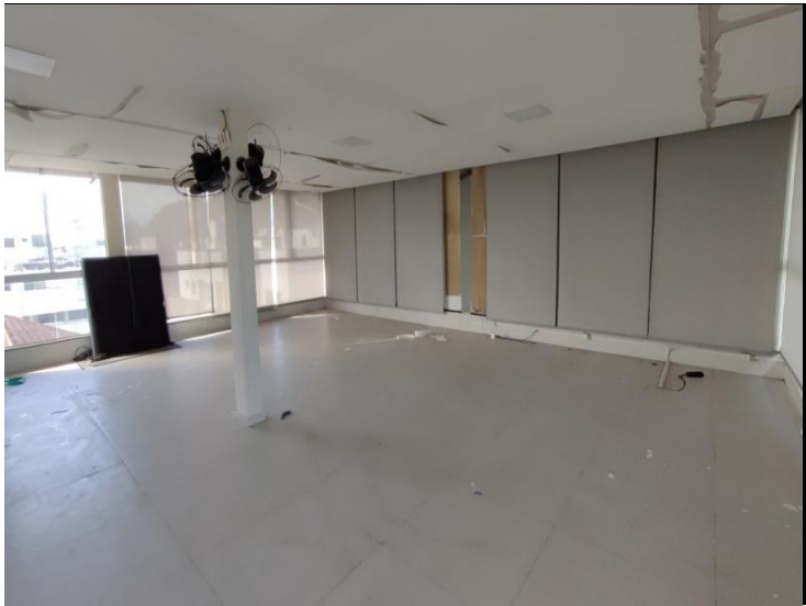
Descrição: VISTA PARCIAL INTERNA DO IMÓVEL
