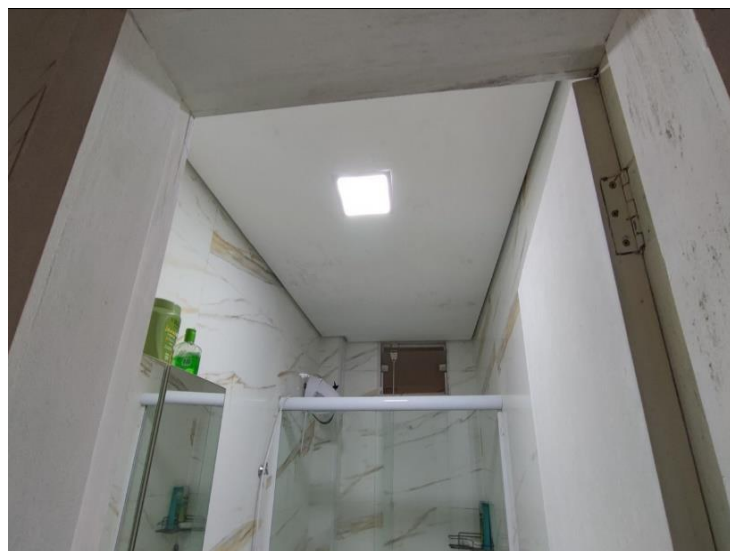
Descrição: VISTA PARCIAL INTERNA DO IMÓVEL
