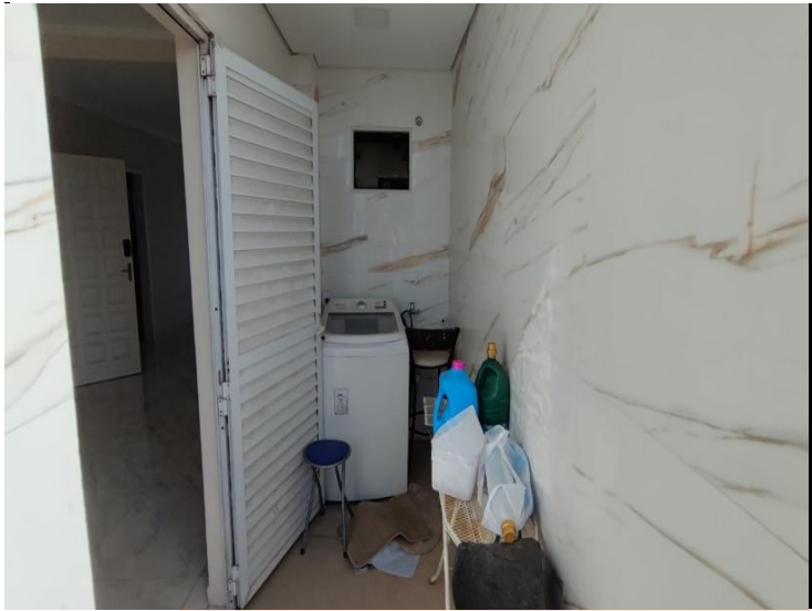
Descrição: VISTA PARCIAL INTERNA DO IMÓVEL
