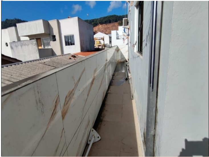
Descrição: VISTA PARCIAL INTERNA DO IMÓVEL
