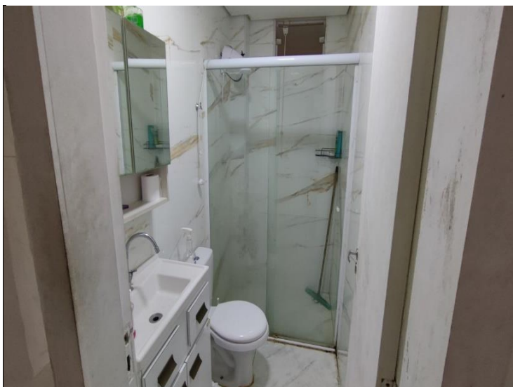
Descrição: VISTA PARCIAL INTERNA DO IMÓVEL
