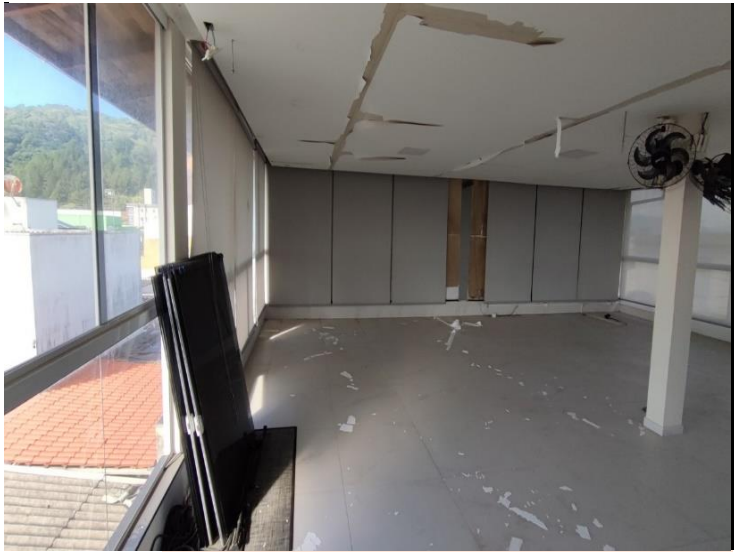
Descrição: VISTA PARCIAL INTERNA DO IMÓVEL
