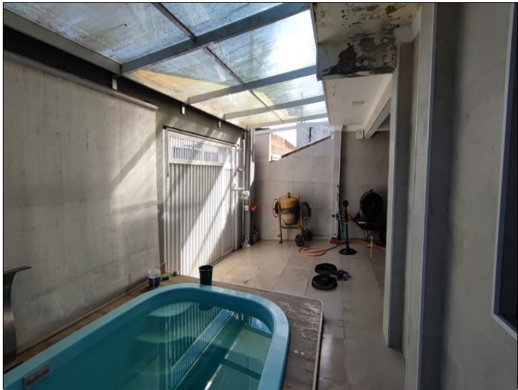
Descrição: VISTA PARCIAL INTERNA DO IMÓVEL
