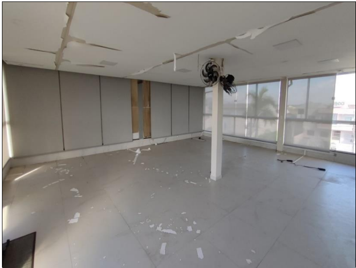
Descrição: VISTA PARCIAL INTERNA DO IMÓVEL
