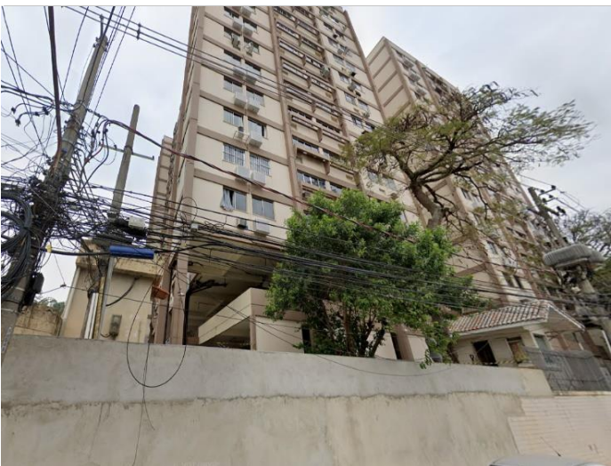
VISTA DA FACHADA DO IMÓVEL EM ESTUDO
