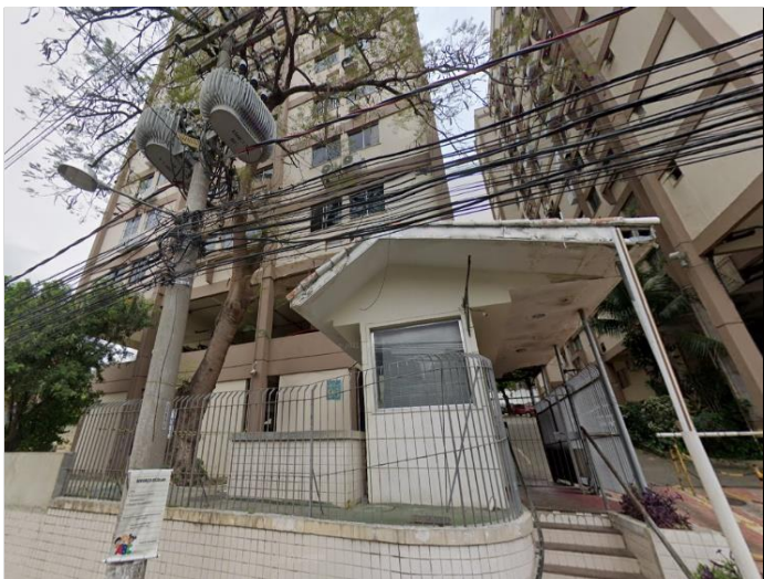
VISTA DA FACHADA DO IMÓVEL EM ESTUDO
