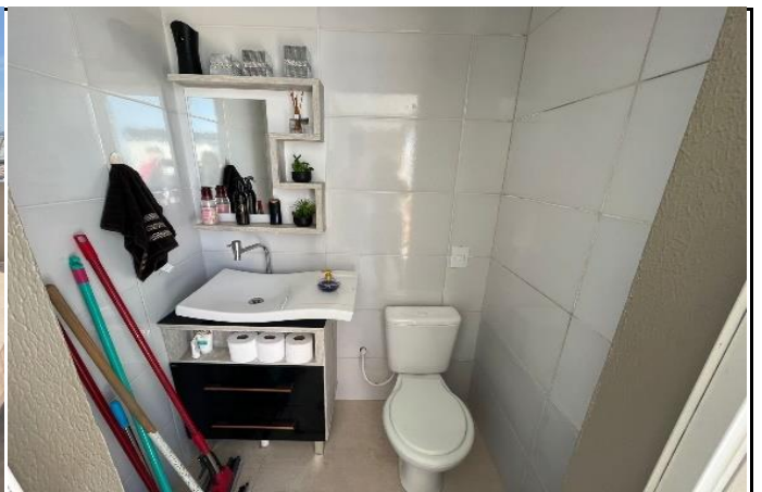
Lavabo - Pavimento inferior
