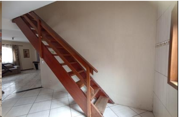
Acesso ao pavimento superior
