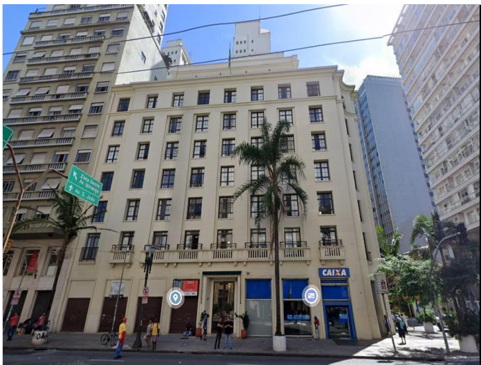
VISTA DA FACHADA DO IMÓVEL EM ESTUDO
