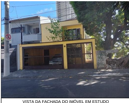
VISTA DA FACHADA DO IMÓVEL EM ESTUDO
