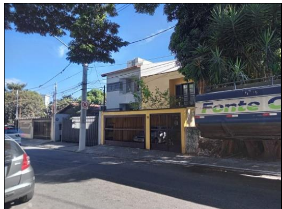
VISTA DA FACHADA DO IMÓVEL EM ESTUDO
