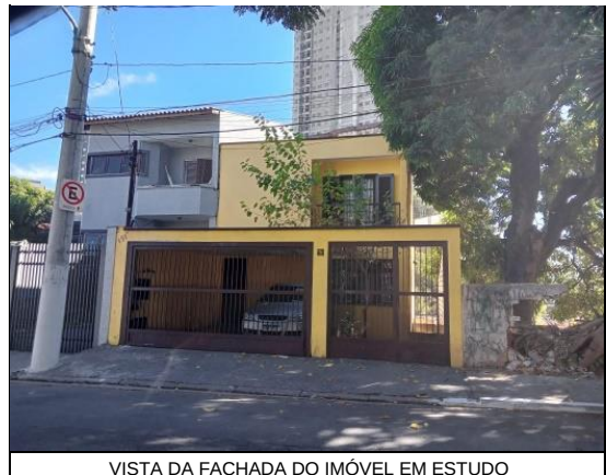
VISTA DA FACHADA DO IMÓVEL EM ESTUDO
