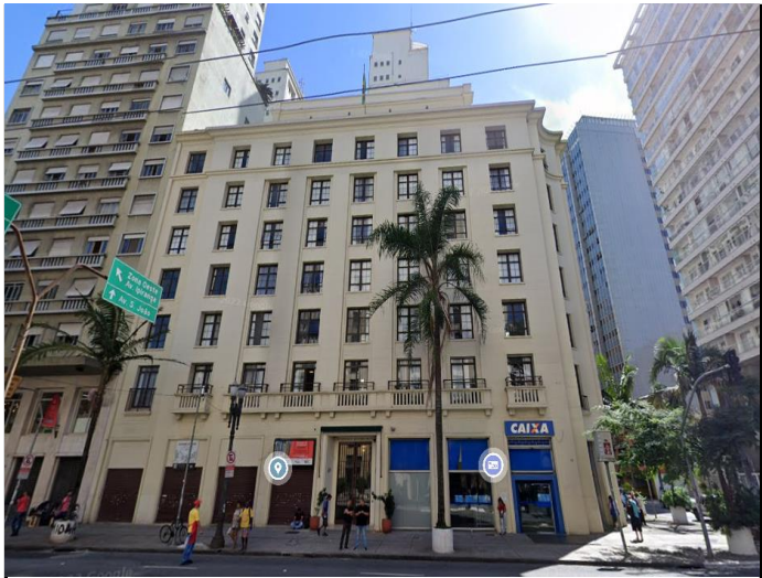
VISTA DA FACHADA DO IMÓVEL EM ESTUDO
