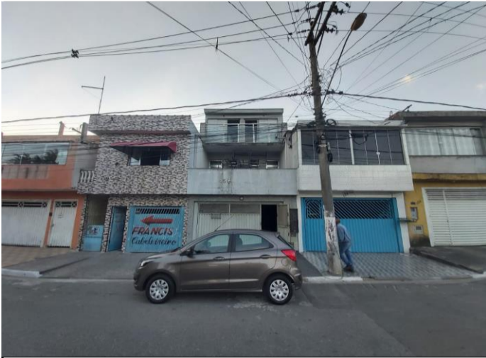
VISTA DA FACHADA DO IMÓVEL EM ESTUDO
