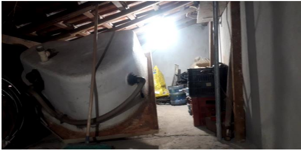
Obra - 2º andar
