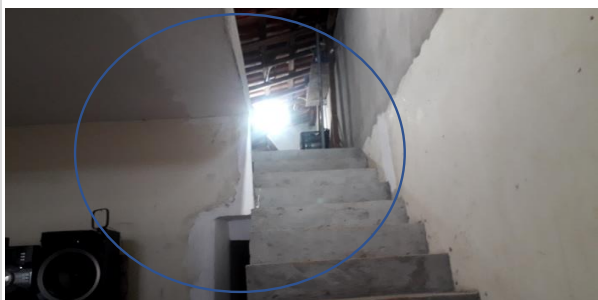
Escada de acesso - 2º pavimento
