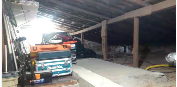
Obra - 2º andar
